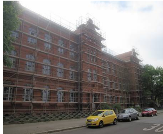
Bsp.: Werner v. Siemens Gymnasium Magdeburg
