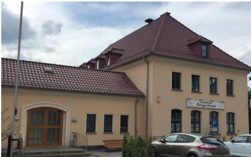
Abbildung 5 – Bürgerhaus Kamsdorf (Foto: TRH)
