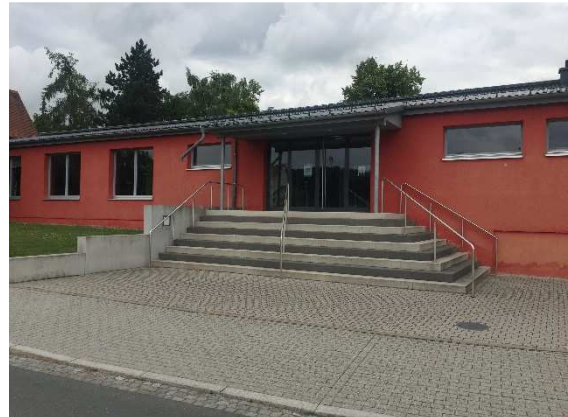
Abbildung 1 – DGH 1 Großschwabhausen (Foto: TRH)
