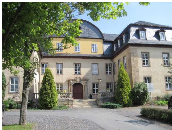
Abbildung 7 – Gemeindezentrum Krölpa (Foto: ALF Gera 26 )
