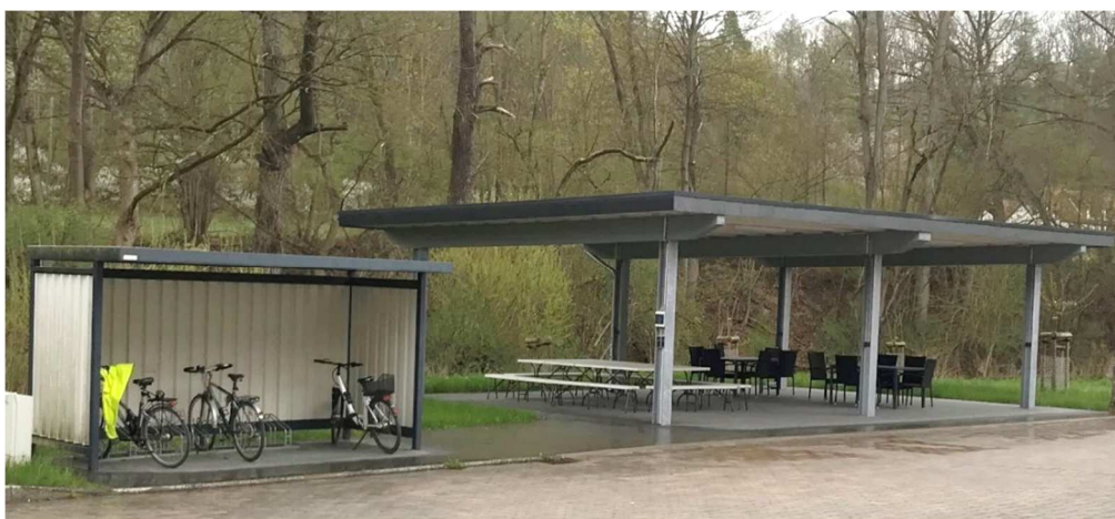
Abbildung 14 Sanierung Außenanlage Alte Mühle
